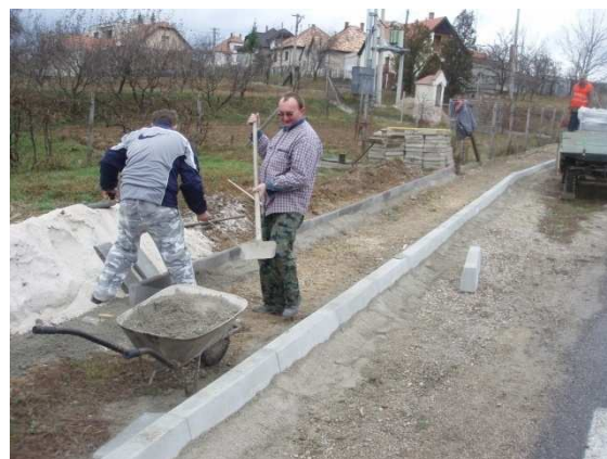
Betónovanie chodníka pri kaplnke 2008
