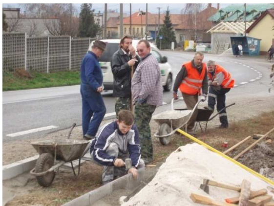
Betónovanie chodníka pri kaplnke 2008
